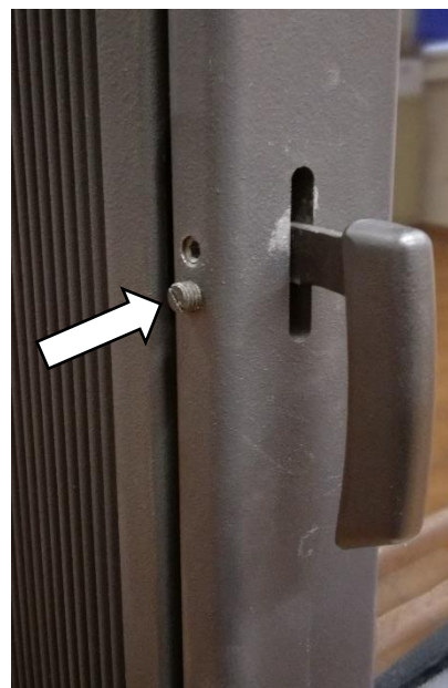
Obr. 15 Šipka vyznačuje umístění pojistného šroubu
